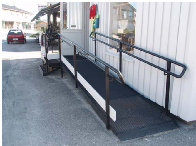
Trapp og rampe av metall i Ødegårdsvegen
